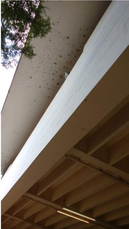
Laje e viga da fachada noroeste, pintadas na cor branco.
