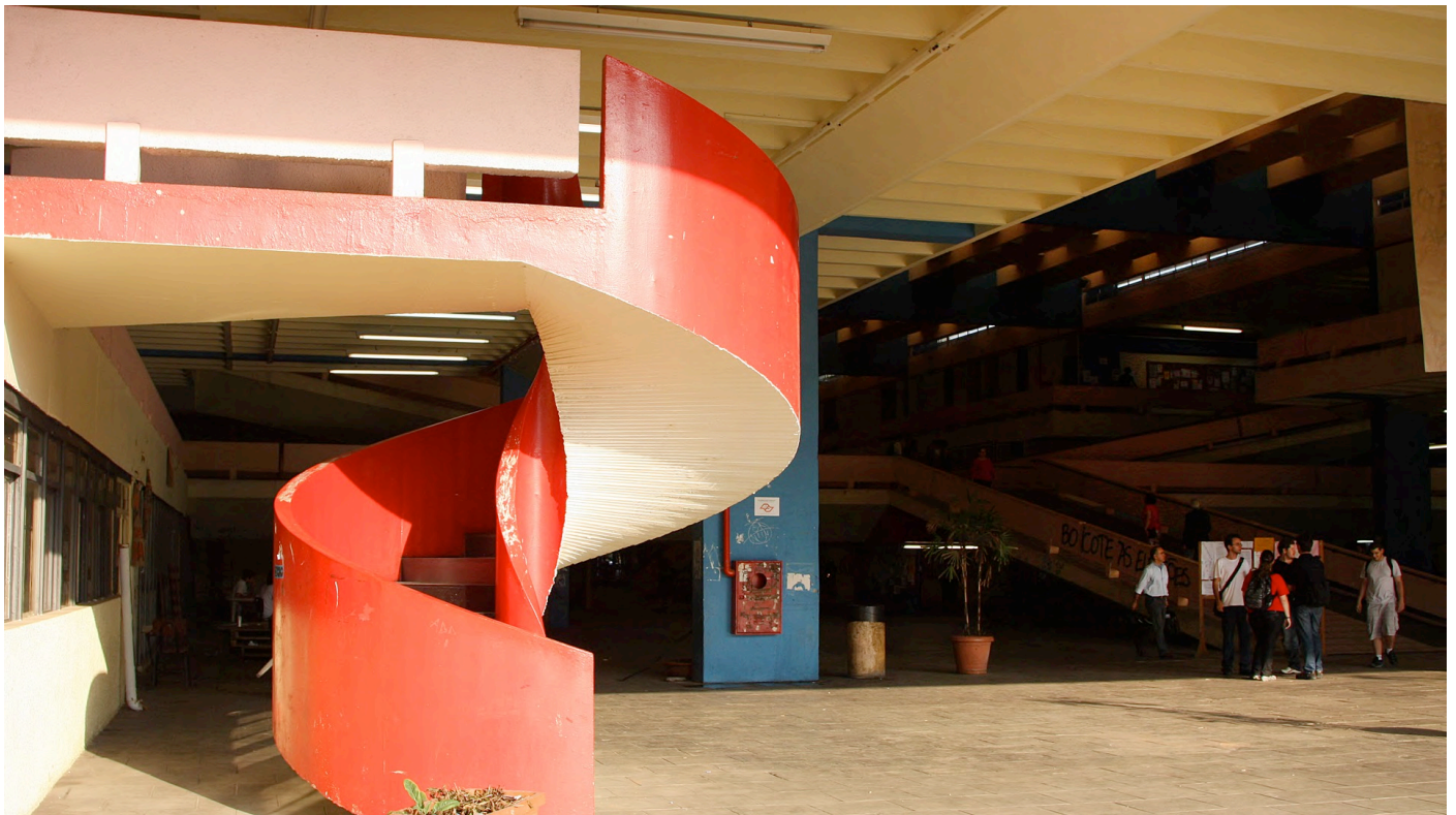
Escada helicoidal junto à fachada noroeste, voltada para as Ciências Sociais. Notar o hidrante instalado no pilar. Foto Marcos Santos, anterior a 2010. Fonte: www.imagens.usp.br
