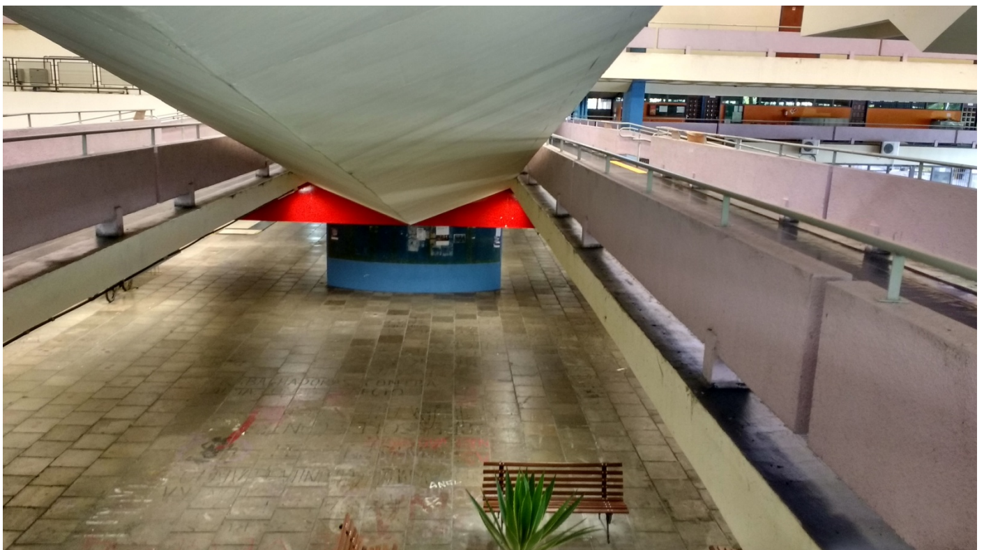
Em primeiro plano rampas e guarda-corpos (em cor violeta claro). No pavimento inferior, piso original em placas de concreto, pilar em azul, parcialmente recoberto, e junção das rampas em vermelho. Ao fundo, no pavimento térreo, alvenarias pintadas em laranja.
