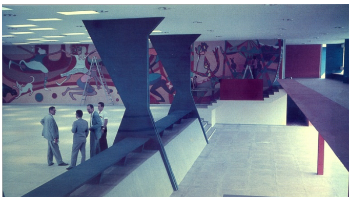
Pátio do Ginásio de Guarulhos, 1960
