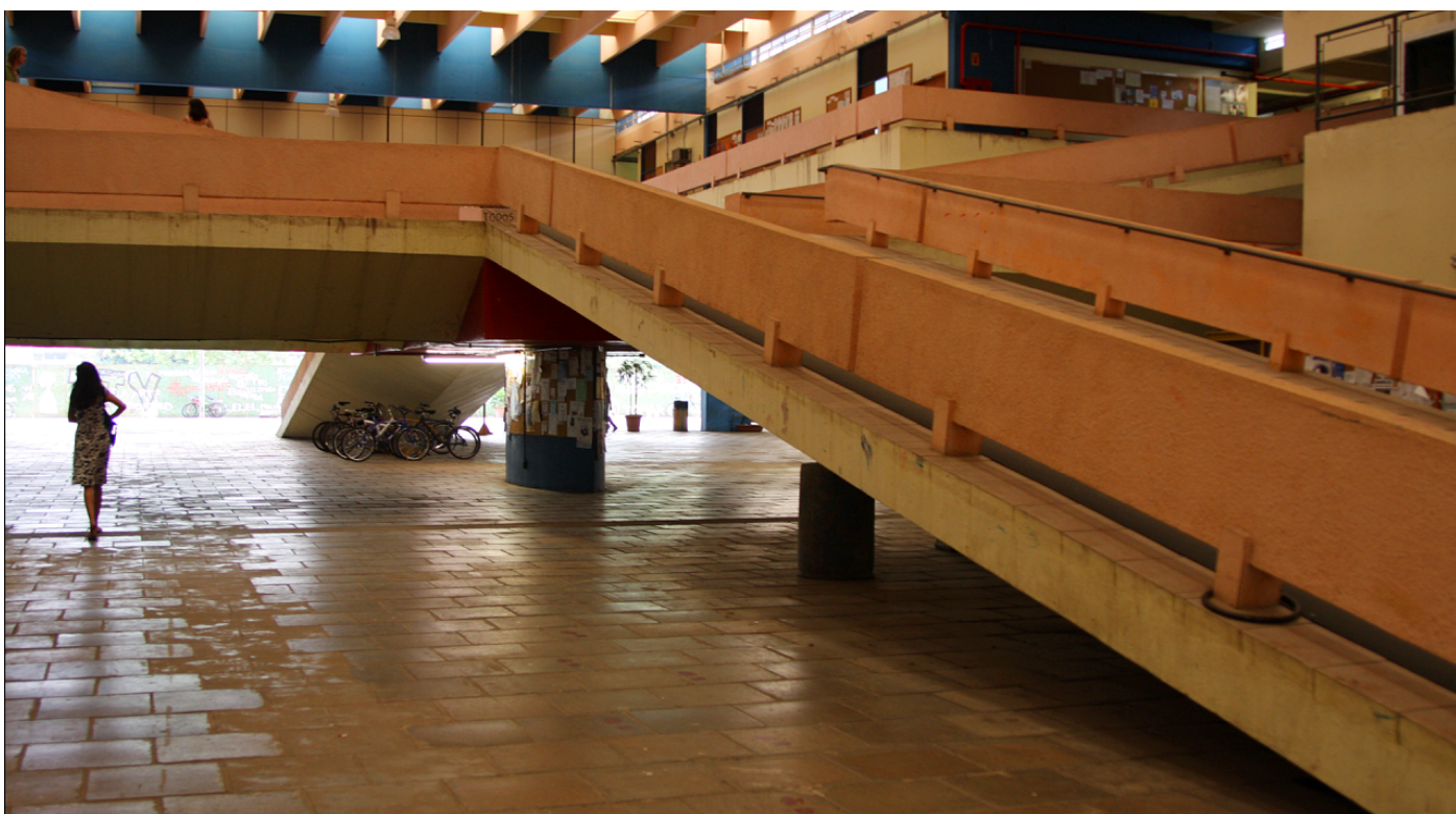
Pilares e viga principal em azul. Guarda-corpos e grelha de cobertura em laranja. Demais elementos na cor creme. Notar que estavam instaladas grades sobre o volume do auditório e sua parede estava pintada. No pavimento superior já estava fechada com divisórias a área junto à fachada noroeste. Foto Marcos Santos, anterior a 2010. Fonte: www.imagens.usp.br .
