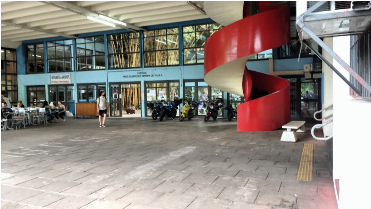
Acesso principal do edifício, com cinza do piso em concreto com acabamento de cimentado queimado, dois tons de azul na transição para o jardim interno, esquadrias em cinza escuro. Notar alteração no edifício original: caixilho, ar condicionado e seu apoio em primeiro plano. Outras interferências visuais, que poderiam ser removidas: banco de concreto, faixa do restaurante, motos estacionadas.
