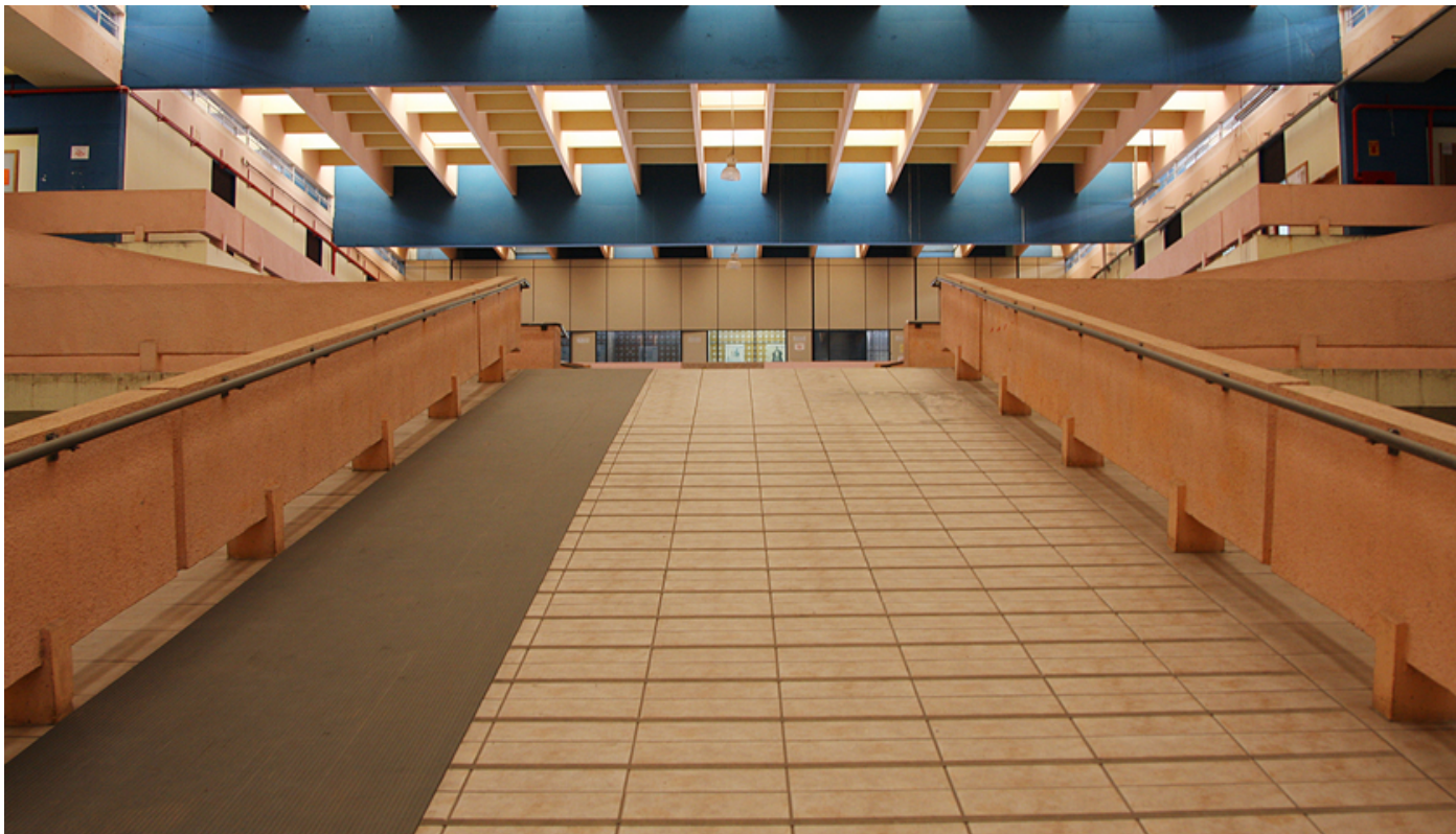
Rampa do edifício do Departamento de História e Geografia, com revestimento em piso cerâmico e faixa lateral antiderrapante. Notar vedação com painéis junto à fachada noroeste, escondendo parcialmente o mural de círculos. Foto Marcos Santos, anterior a 2010. Fonte: www.imagens.usp.br .
