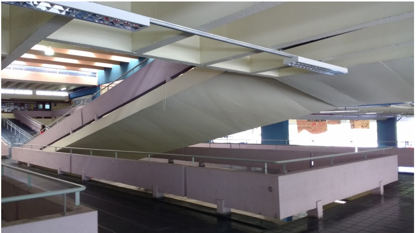
Foto do saguão central e das rampas, com pilares e vigas principais na cor azul, rampas em amarelo claro, guarda-corpos de concreto em cor violeta claro, tubos metálicos em cinza claro e piso em ladrilhos hidráulicos cor cinza escuro. Em primeiro plano, iluminação diferente da original.
