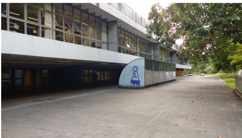
Acima e ao lado: abrigos para iluminação e ventilação não originais na fachada sudoeste.
