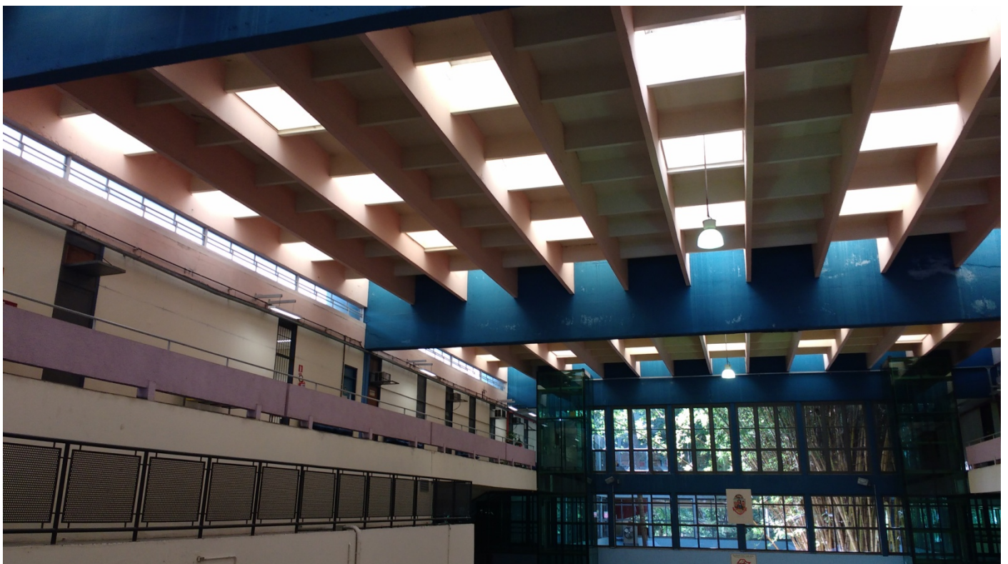
Saguão central. Notar à esquerda grade acrescentada sobre volume de entrada do auditório e aparelhos de ar condicionado instalados junto à bandeiras de portas do pavimento superior.
