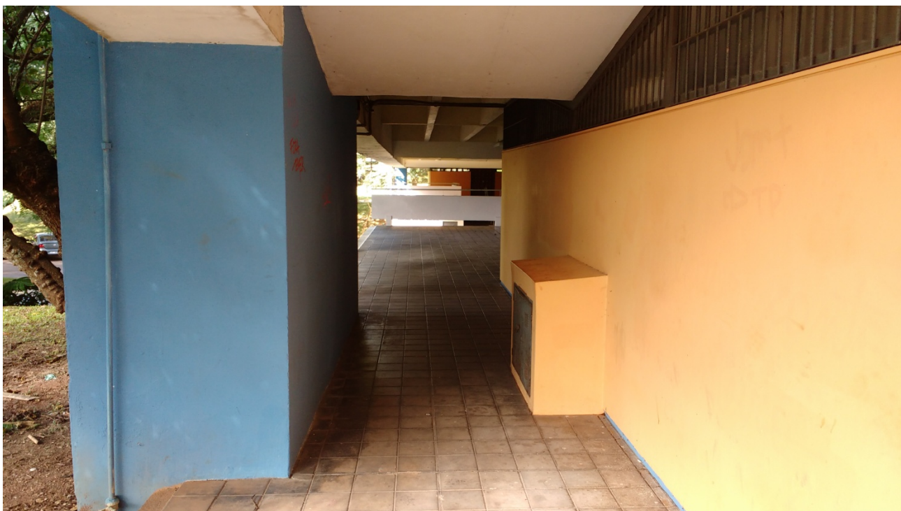
Fachada voltada para a avenida Professor Lineu Prestes, com pilares em azul, vigas em branco, alvenarias em laranja e guarda-corpo branco. Piso em ladrilhos hidráulicos na cor cinza, que identificam o pavimento térreo. Notar o abrigo e grades acrescentados ao edifício original.
