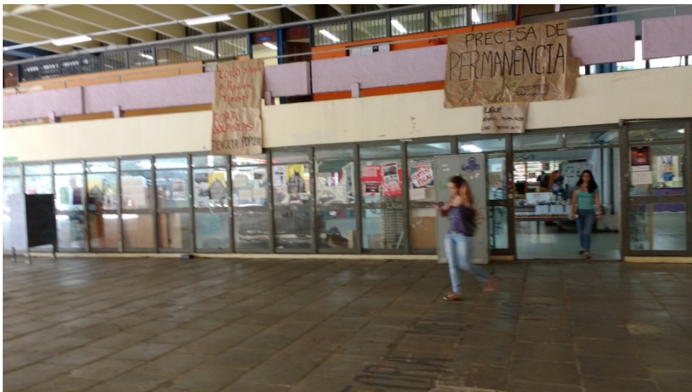
Esquadrias em cinza escuro; guarda-corpo de concreto na cor violeta claro e ao fundo alvenaria na cor laranja. Restante do concreto na cor branco; cinza do piso em placas de concreto na cor natural com acabamento liso, que apresenta um brilho discreto.
