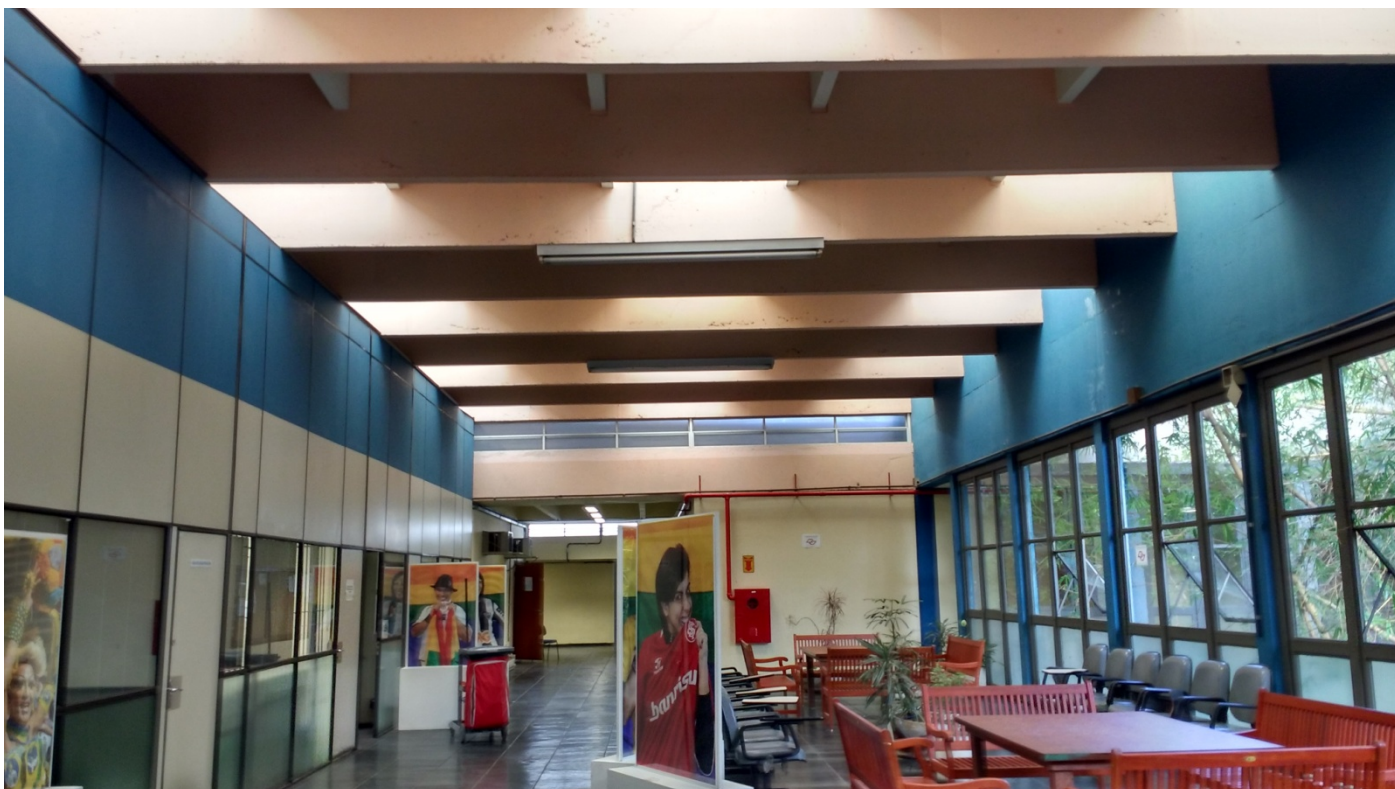
À esquerda divisórias acrescentadas ao prédio original. Vigas secundárias em tom creme e alvenaria branca, como as demais do pavimento superior.
