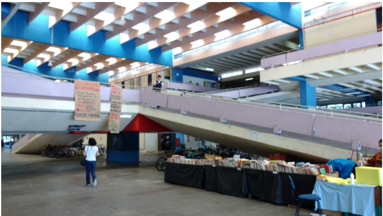
Foto do saguão central e das rampas, com pilares e vigas principais na cor azul e junção das rampas em vermelho
